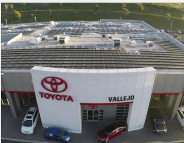
Toyota of Vallejo a installé un système de capteurs solaires en toiture de 251 kW qui compense en moyenne 61 % des besoins en électricité de la concession.
